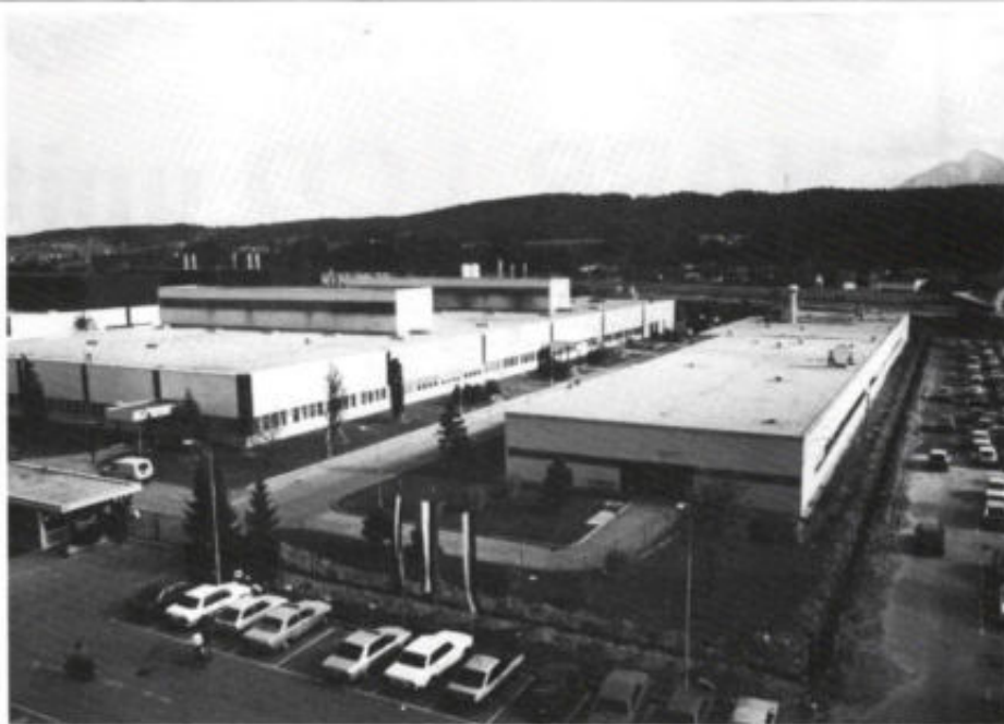
8000 m 2 grote halfgeleiderfabriek van Siemens in Villach in de oostenrijkse provincie Kärnten.
